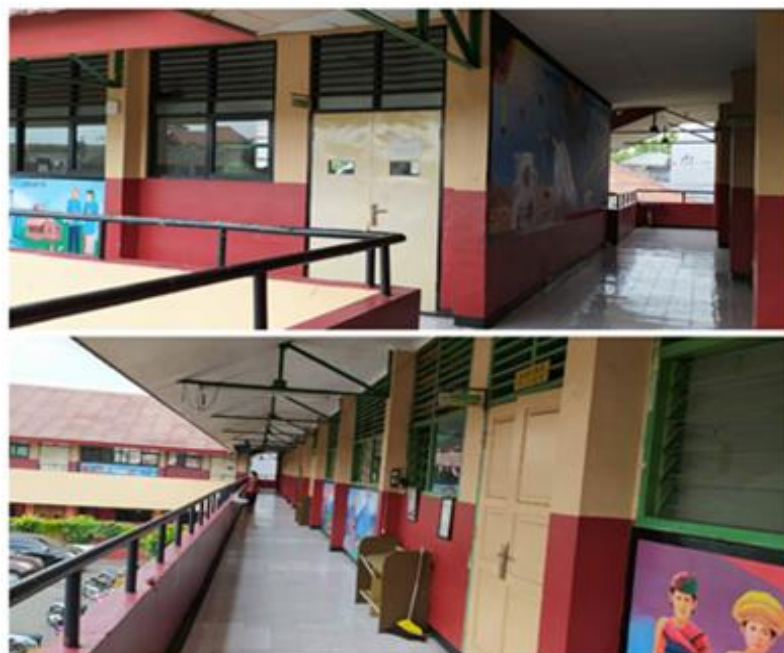
Gambar 2. Gedung SDN 09 Makasar lantai 2
